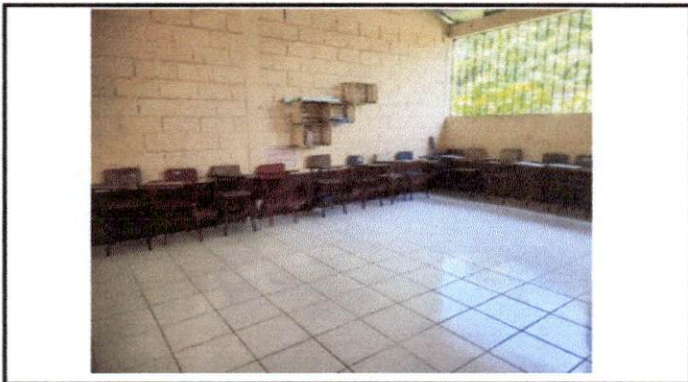
Foto 4: Piso cerámico finalizado, en las aulas.
